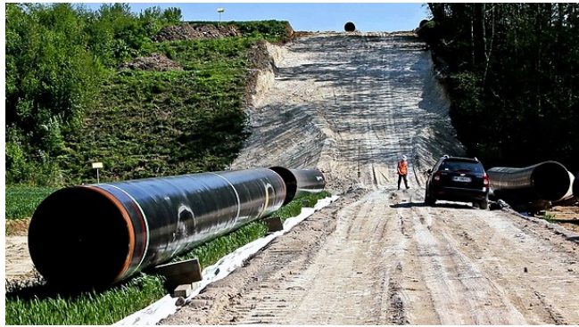
Hauts de France II - Tubes bardés le long de la piste
