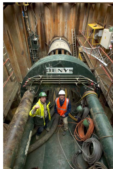
Microtunnelier à Serpaize (38)
