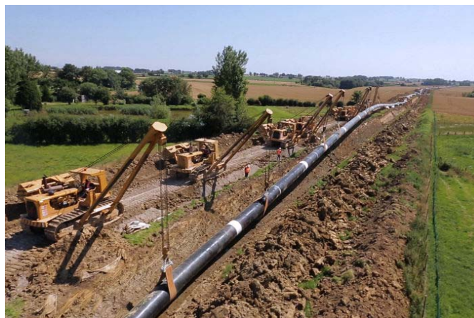
Hauts de France II : Mise en fouille d'une canalisation (59)
