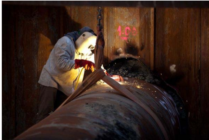
Hauts de France II - opérations techniques de soudure
