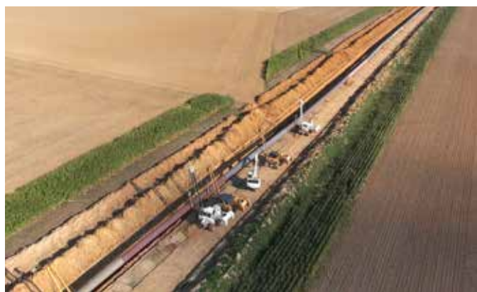
Chantier de pose d'une canalisation de gaz naturel
