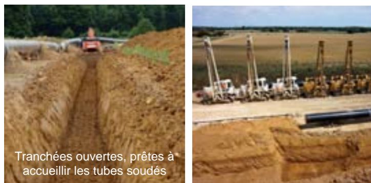
Ouverture par trancheuse pour les sols rocheux
