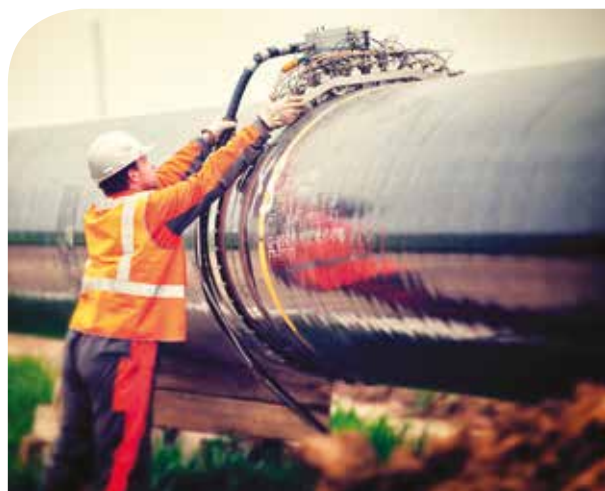
Contrôle non-destructif des soudures © GRTgaz, Antoine Aybes
