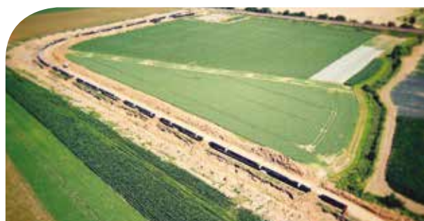
Vue aérienne, chantier Hauts de France II © GRTgaz
