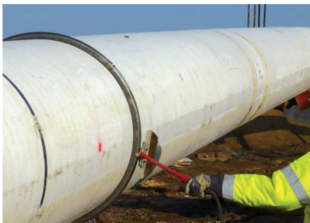
Contrôle au balai électrique
