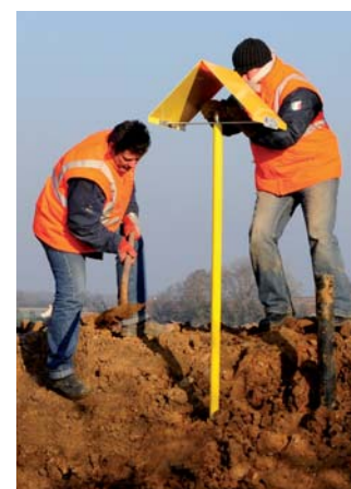
Mise en place d'une balise
