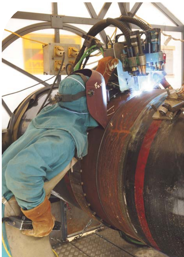
Soudure automatique sous abri
