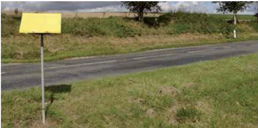
Balise et borne de signalisation indiquant la présence d'une canalisation de transport de gaz naturel
