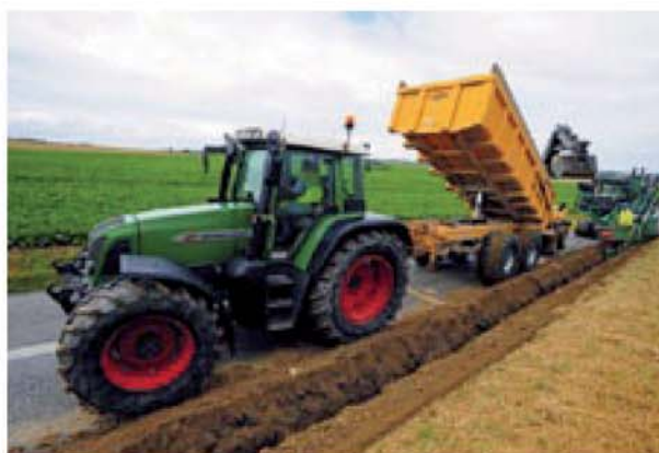
Enfouissement de ligne à Frémainville (Val-d'Oise) : creusement d'une tranchée et enfouissement de câbles à l'aide d'une trancheuse
