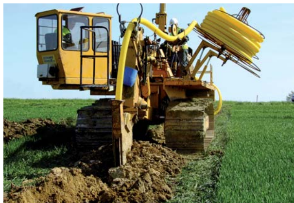
Draineuse en action
