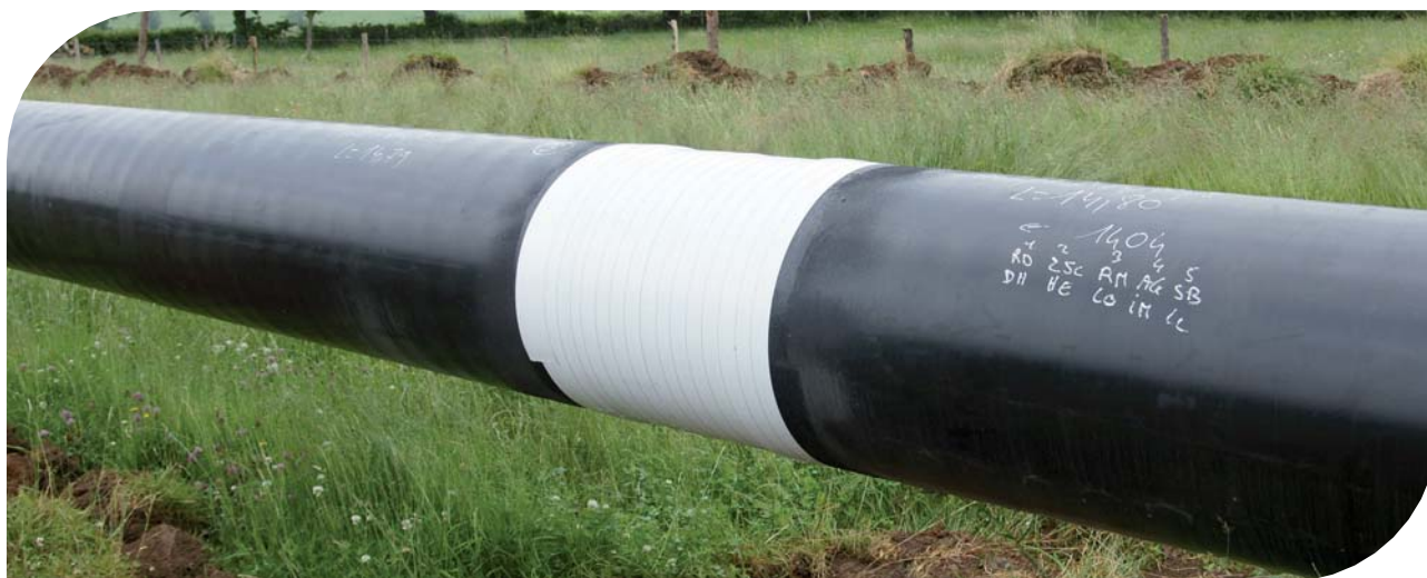
Mise en place d'un système de bandes enroulées
