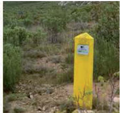
Balise et borne de signalisation indiquant la présence d'une canalisation de transport de gaz naturel
