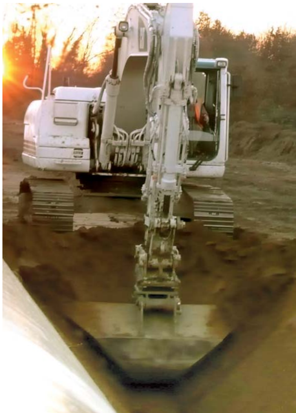
Ouverture de la tranchée
