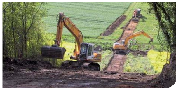
Décapage de la terre végétale
