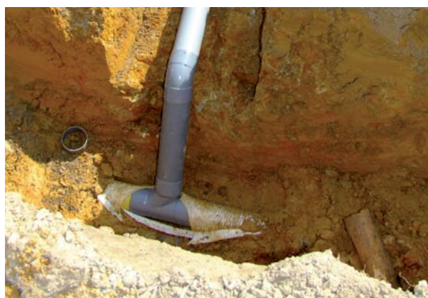
Drain mis en place
