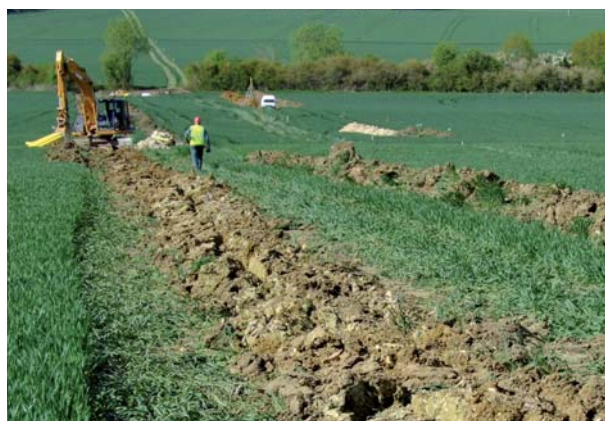
Drainage en cours
