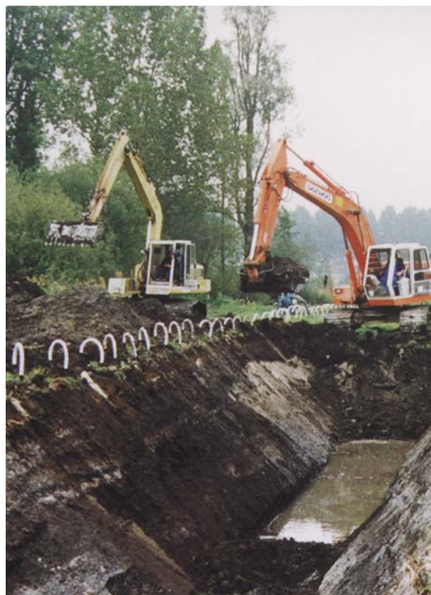
Réseau de cannes de pompage mis en place dans le sol
