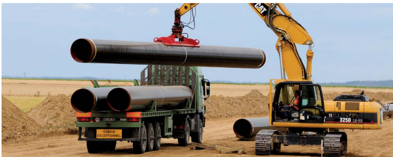
Déchargement des tubes sur piste
