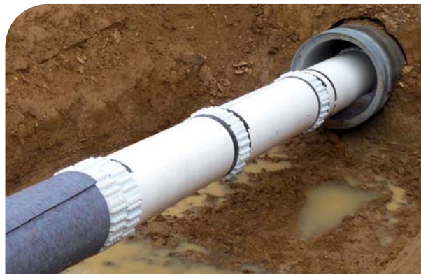
Tronçon de canalisation à l'intérieur d'un busage
