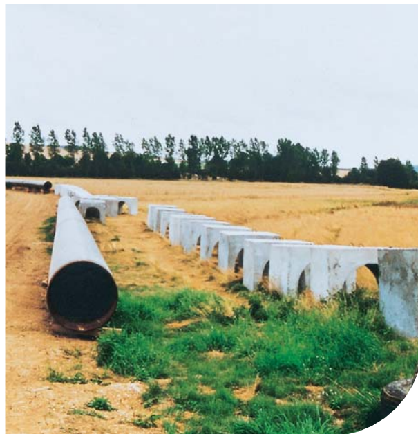
Cavalier de lestage béton bardés avant mise en place
