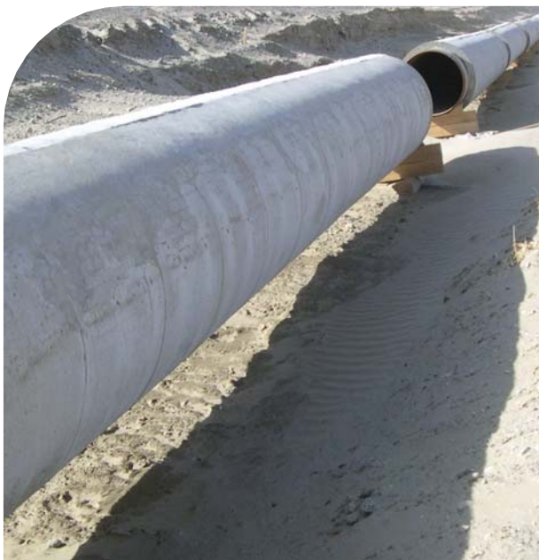
Tube en béton continu pour lestage en zone humide
