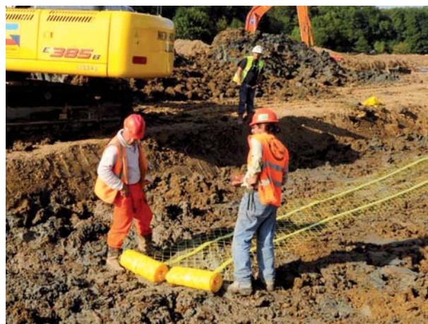
Installation d'un grillage avertisseur
