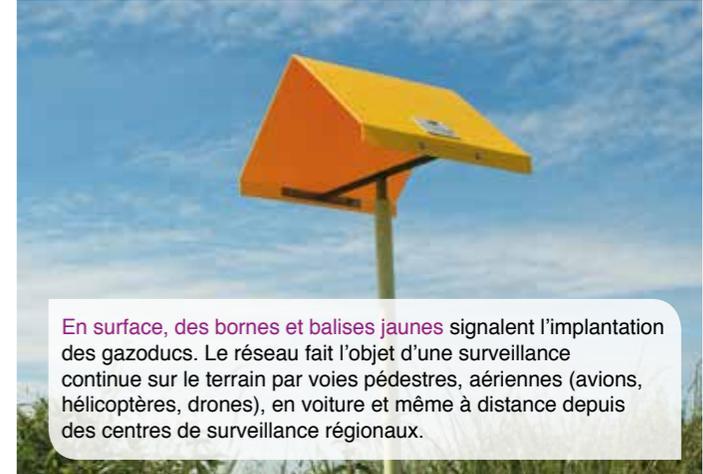
En surface, des bornes et balises jaunes signalent l'implantation des gazoducs. Le réseau fait l'objet d'une surveillance continue sur le terrain par voies pédestres, aériennes (avions, hélicoptères, drones), en voiture et même à distance depuis des centres de surveillance régionaux.
