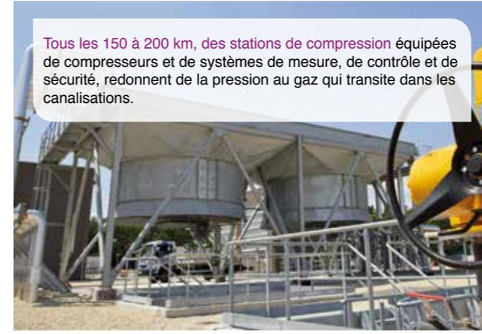
Tous les 150 à 200 km, des stations de compression équipées de compresseurs et de systèmes de mesure, de contrôle et de sécurité, redonnent de la pression au gaz qui transite dans les canalisations.
