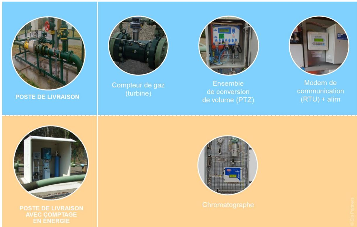
Figure 3 : Appareils de mesure présents sur les postes de livraison aux clients industriels
